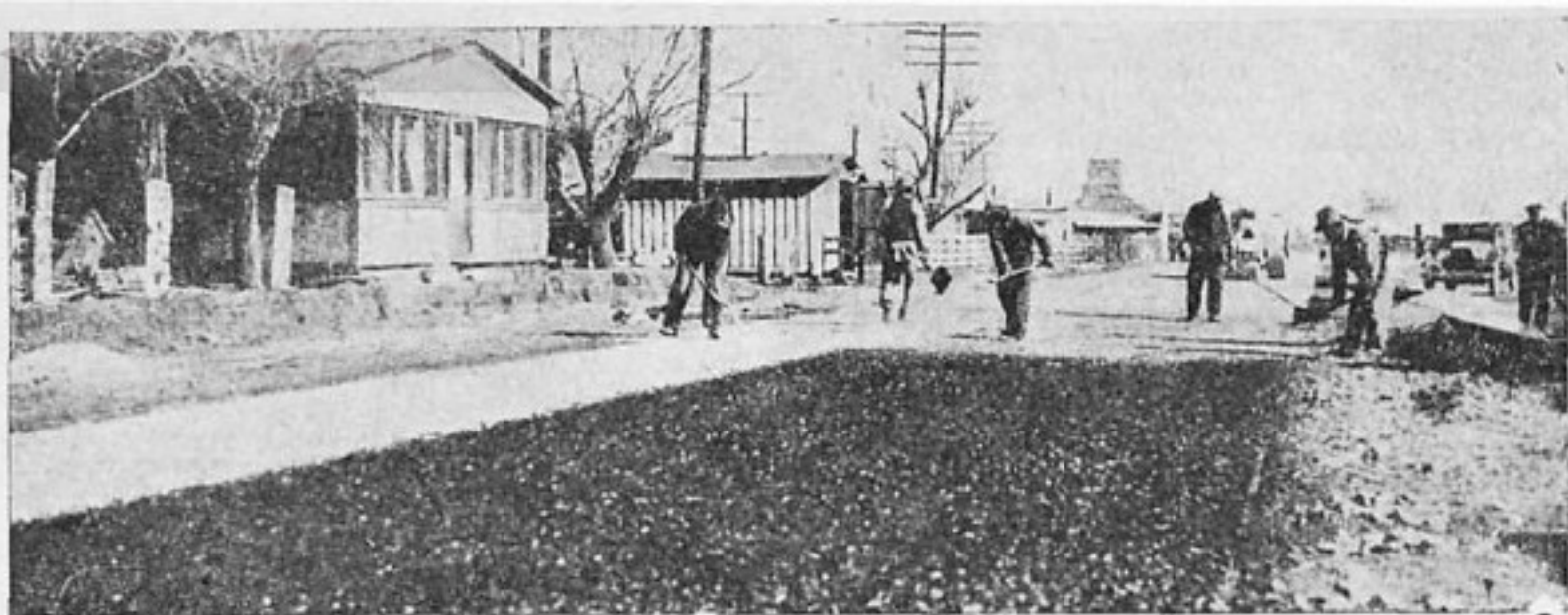
Дорожные работы в Соединенных Штатах. После пропитывания дорогу посыпают мелкими камнями
