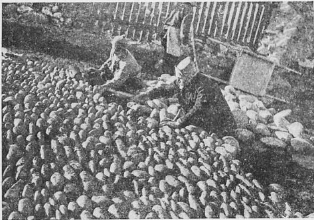
В Таджикистане усиленно разворачивается дорожное строительство.
